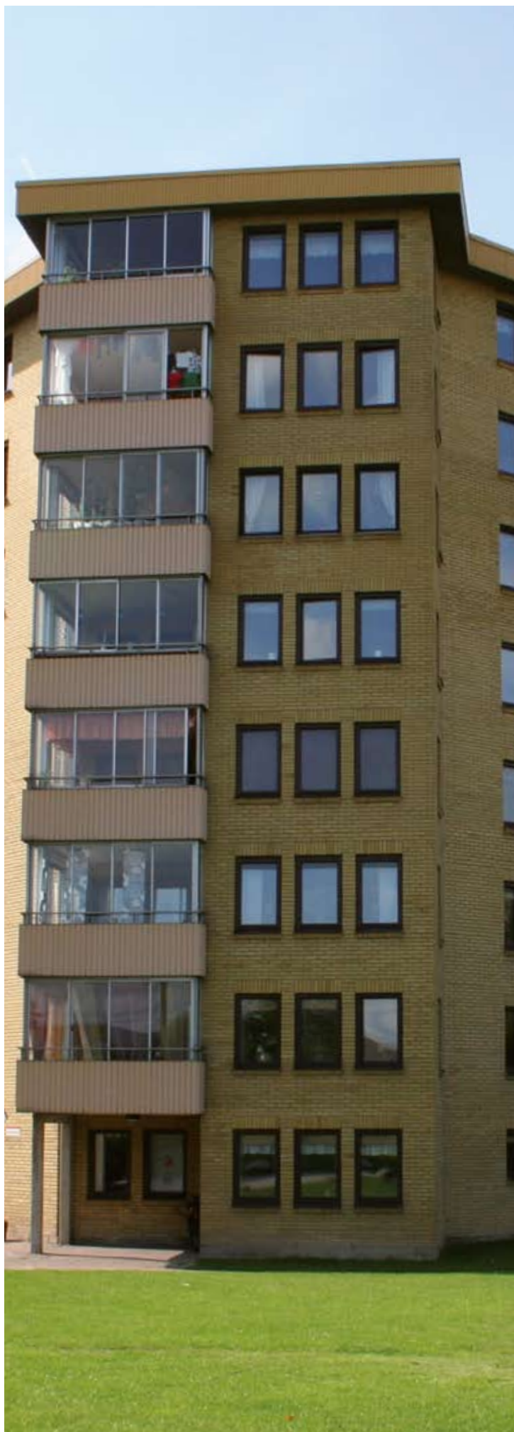
Hyresgästerna på Virvelvägen 301 är först ut att få det nya bredbandsnätet installerat.
